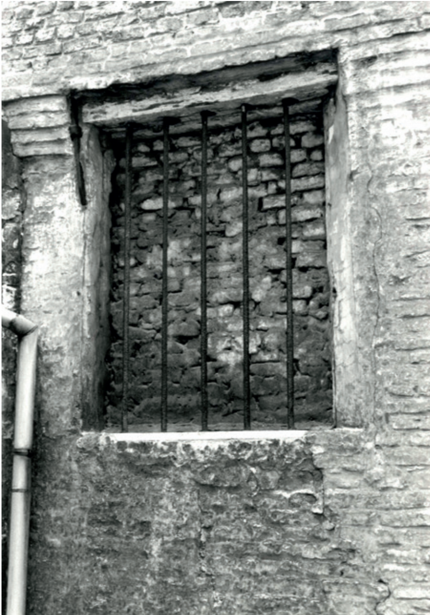
Sint-Jansstraat 13, Brugge © Dienst Monumentenzorg Stad Brugge. Bij renovatiewerken in 1999 trof men in de oostgevel van deze woning een dichtgemetseld raam aan. De tralies die directe inblik bij de burens onmogelijk moesten maken, waren nog aanwezig. Ze zijn geconserveerd bij de verbouwing.
