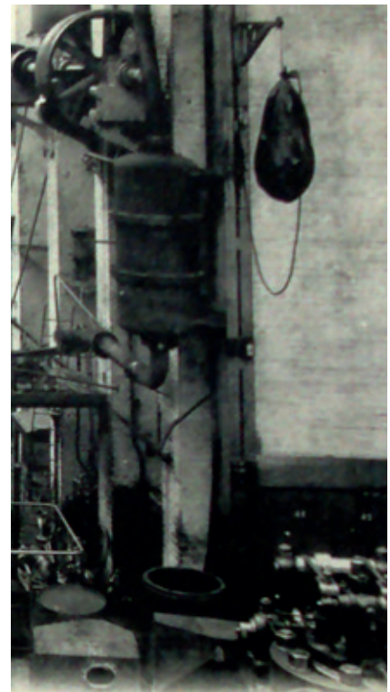
Een booglamp in de werkhuizen Carels in beschermhoes tegen het overvloedige stof bij niet-gebruik (collectie André Verbeke). Interessant is hier vooral het hijsysteem dat toeliet de lamp naar beneden te halen om de koolspitsen bij te stellen.
