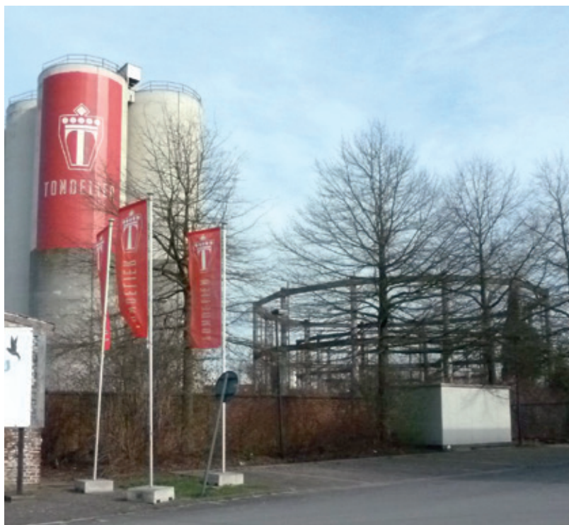
Zelfde gashouder of 'gasklok' (foto 2015) met publiciteit voor het project woonpark Tondelier. De tank (rechts) is leeg; hij is volledig onderaards gezakt in een reusachtig waterreservoir, eigen aan dit type 'natte' gashouders. Bij vulling met gas wordt de gashouder omhoog gestuwd zoals op de afbeelding hiernaast te zien is. De dichting van deze reusachtige 'klok' zonder bodem wordt verzekerd door een watermantel op de bodem en er omheen tot op het maaiveld. De inhoud wordt 'gemeten' aan de hand van de hoogtestand: vandaar de termen gazometer, 'gasmeter' en Gasmeterlaan.
