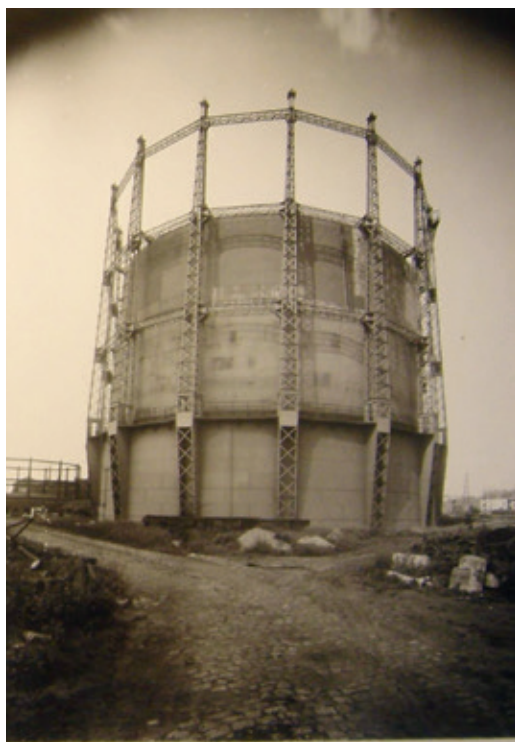
Gashouder (gasmeter, gazometer, in gevulde toestand) van het stedelijk gasbedrijf aan de Gasmeterlaan (foto 1943, Stadsarchief Gent, fotoverzameling Stedelijke Commissie voor Monumenten en Stedschoon nr. 7371).
