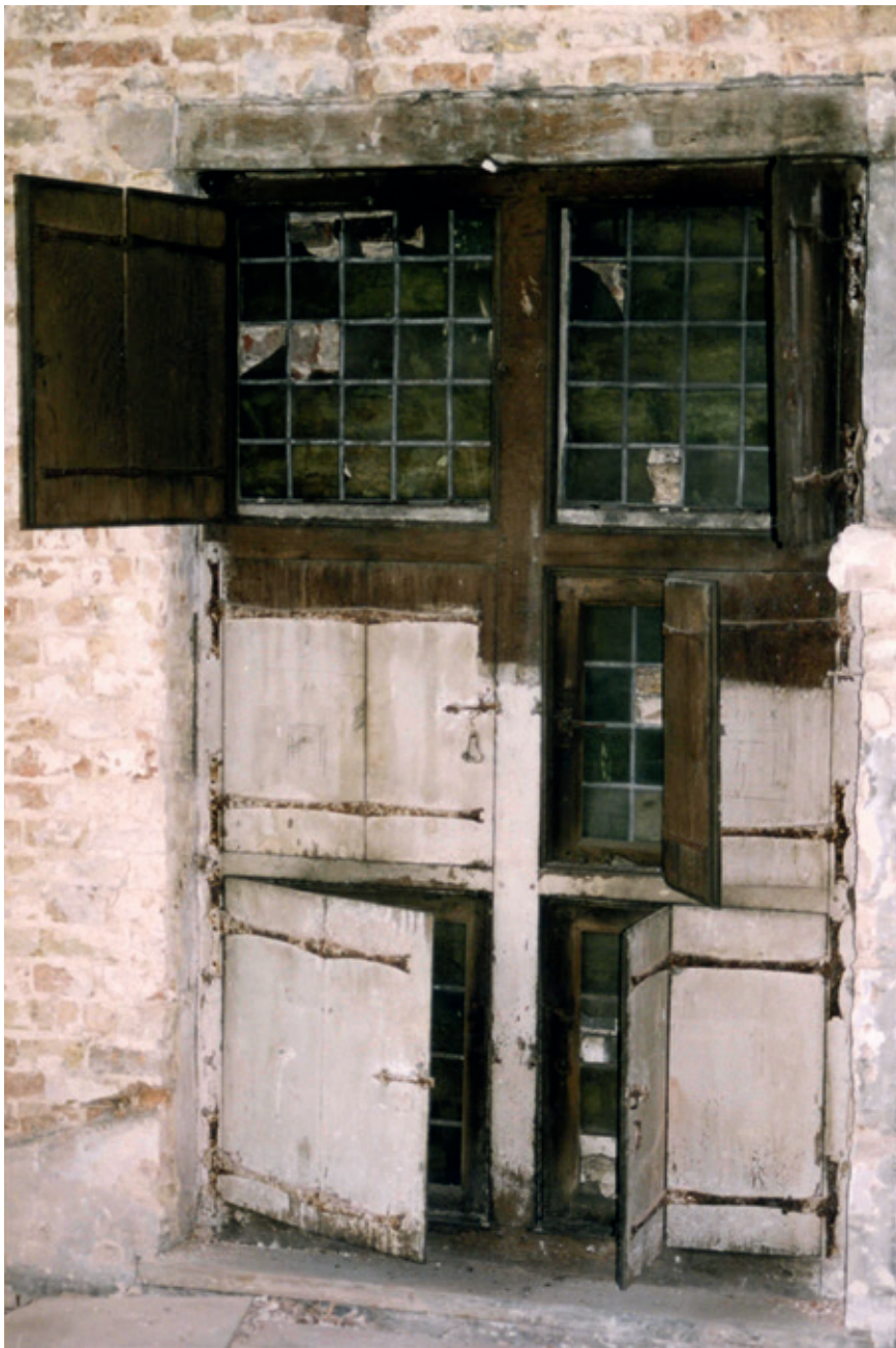
Sint-Jansstraat 13, Brugge © Dienst Monumentenzorg, Stad Brugge. Bij renovatiewerken in 1999 vond men achter houten planken dit laatgotisch venster (16 de of 17 de eeuw). De houten luikjes en zelfs het donkergekleurde glas waren vrij intact bewaard.
